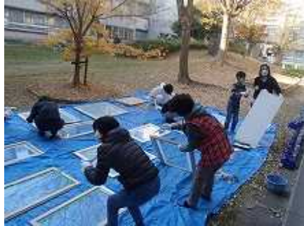
窓枠のペンキ塗り
